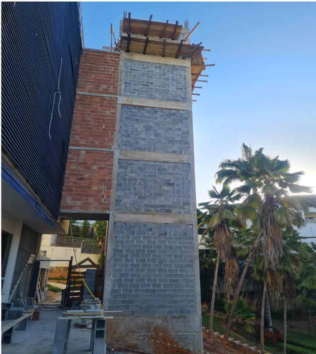
*Figura 1 :Alvenaria de blocos de concreto*
