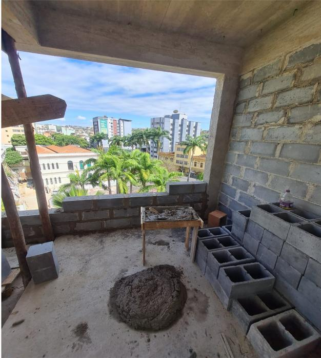
**Figura 1 : ALVENARIA DE BLOCOS DE CONCRETO
