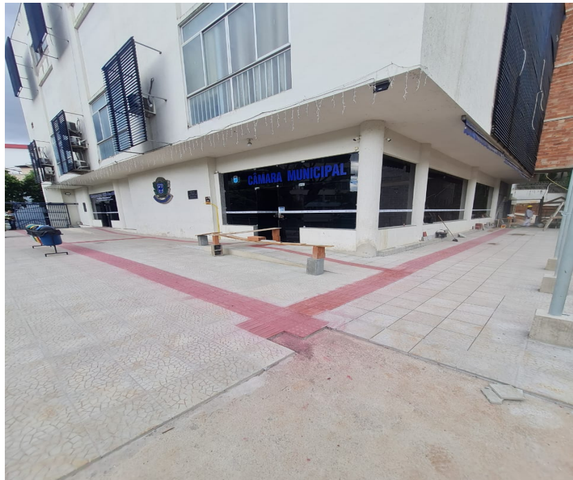
FIGURA 2: INSTALAÇÃO DE LADRILHO HIDRÁULICO
