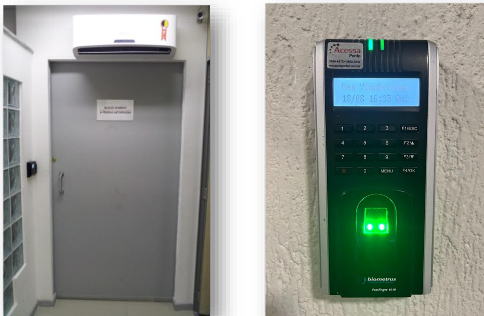
FIGURA 02 – AMBIENTES CLIMATIZADOS, SEGUROS E COM ACESSO DIGITAL
