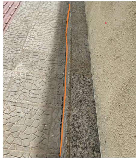
F01: Trincas no piso externo
