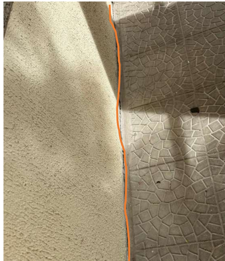
F01: Trincas no piso externo
